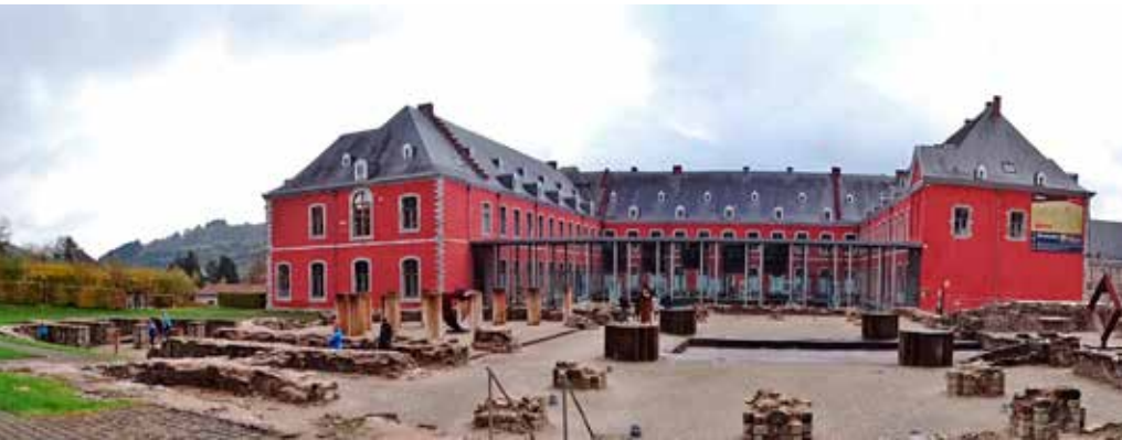
De abdijsite beheerst het stadje Stavelot.
